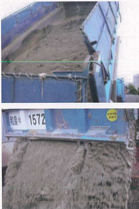
写真-2 貯蔵設備への投入状況
