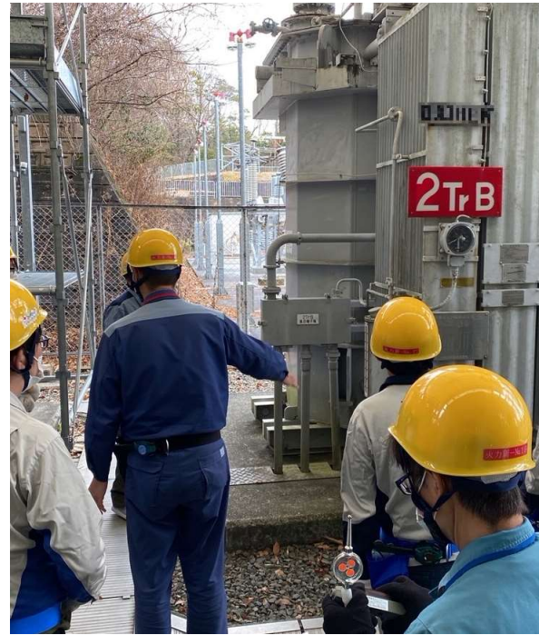
変圧器（巡視点検ポイント解説,負荷時タップ切替器トルク測定）
