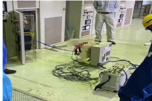
6.6kV Cub（開閉時間特性試験）
