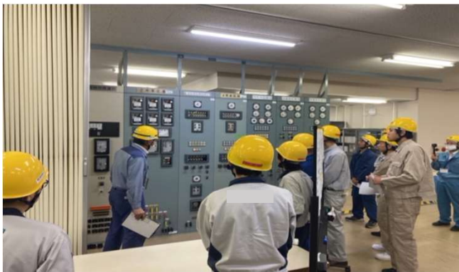
配電盤（PCTテストプラグ操作）
