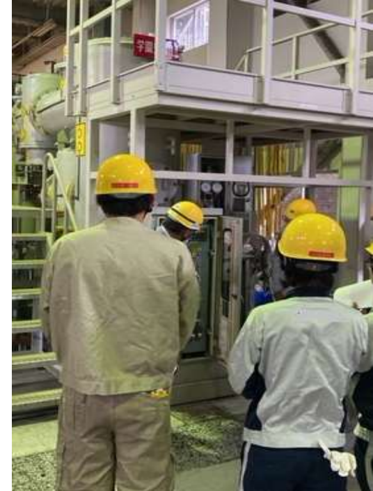
GIS（監視盤点検）
