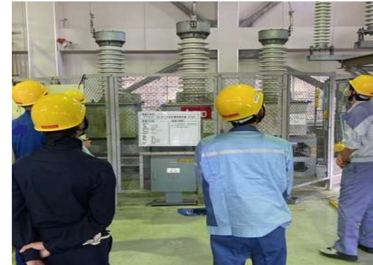
77kV PD（外観点検）
