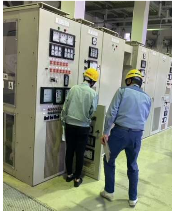
6.6kV Cub（遮断器投入/開放）
